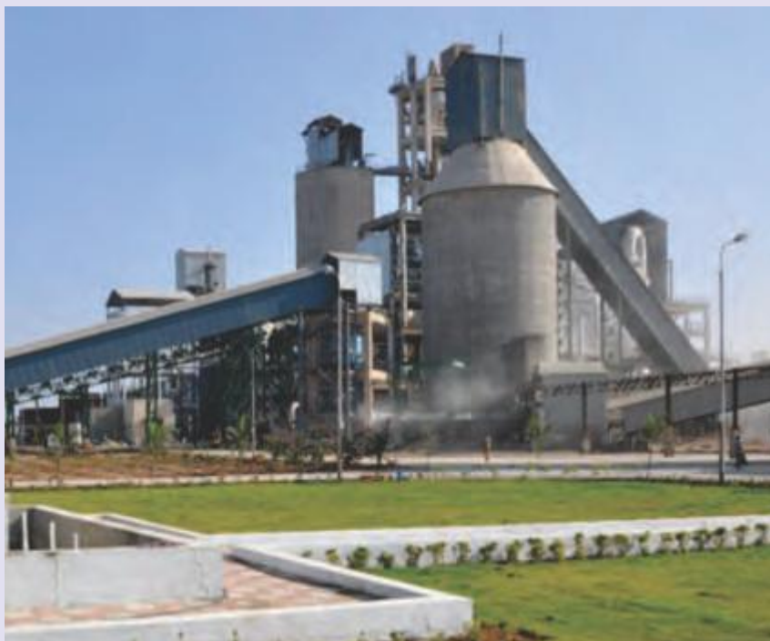
TNPL's Mini Cement Plant
